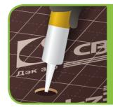
Combler les trous réalisés au court des travaux par une colle à base de silicone afin de sceller les entrées d'humidité
